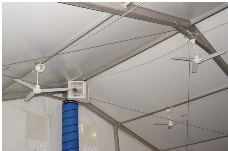
Abb1. Einbringung von H<sub>2</sub>O<sub>2</sub> in First-Nähe
